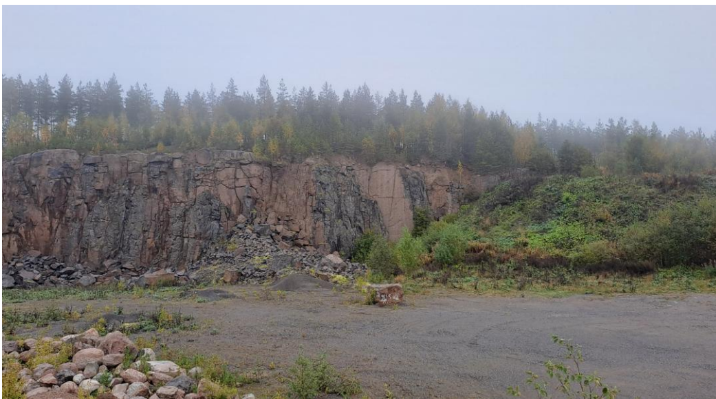
Kuva 10. Kuvassa näkyy louhitun alueen pohjaa sekä kuvan oikeassa reunassa louhitun alueen koillisnurkkaa, jota on aloitettu luiskaamaan maa-aineksilla. Lähde: Destia Oy 18.9.2025.
