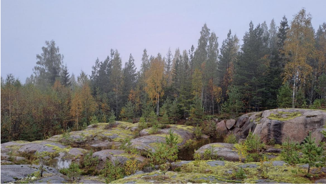
Kuva 11. Louhinta-alueen luoteisosan kuorittua kalliota. Lähde: Destia Oy 18.9.2025.
