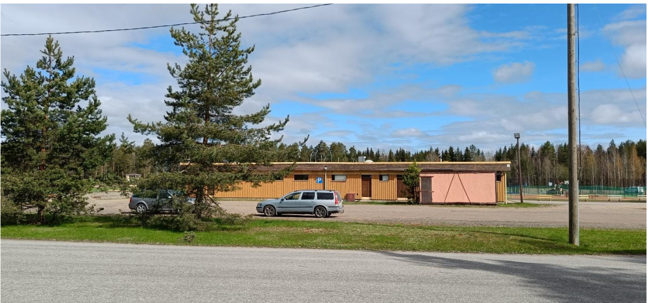
Kuva 9 Raviradan reunalla oleva pukukoppirakennus 1970-luvulta.
