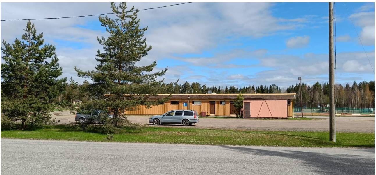
Kuva 9 Raviradan reunalla oleva pukukoppirakennus 1970-luvulta.
