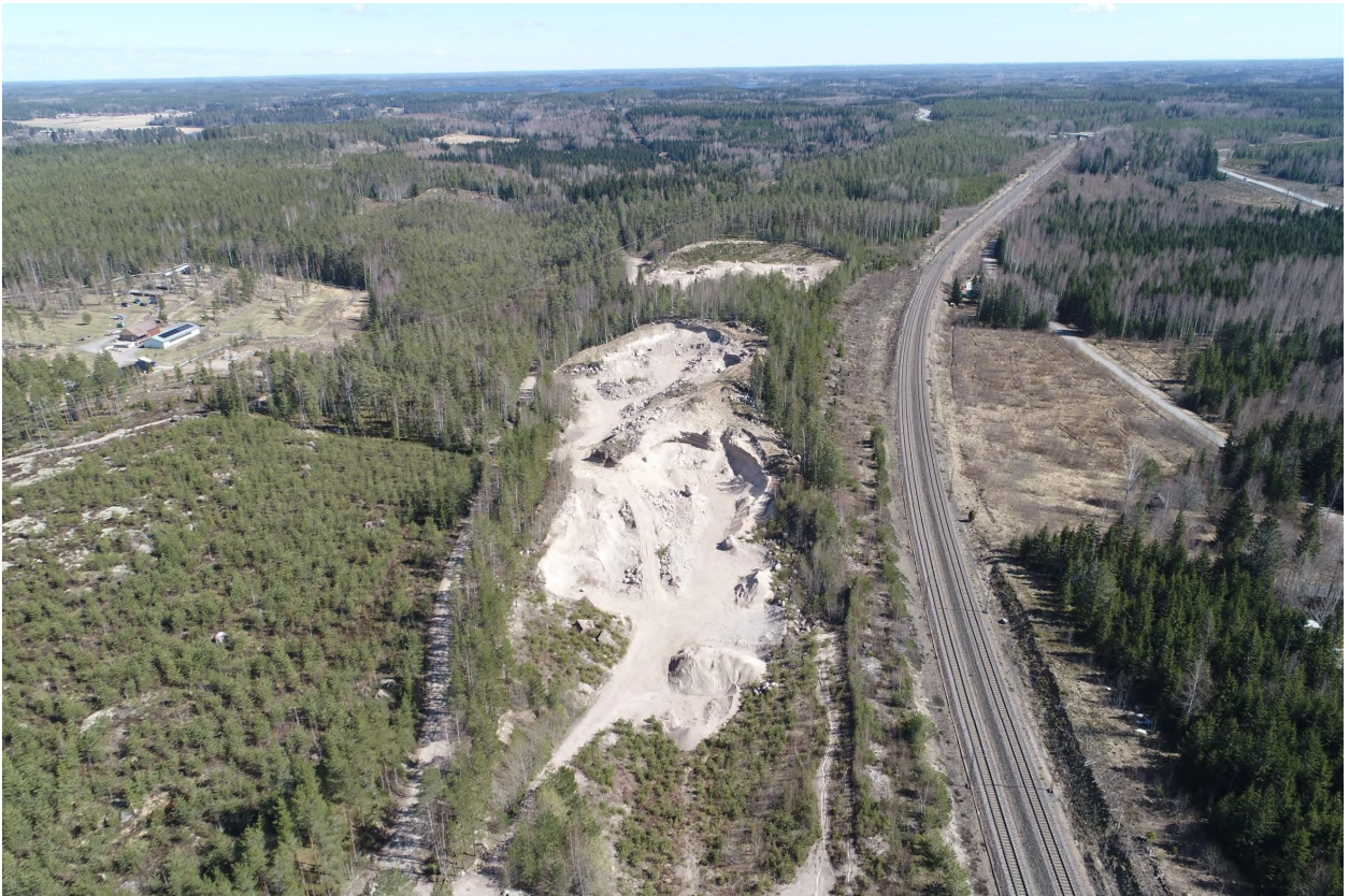
Kuva 3: Ottoalue idän suuntaan kuvattuna 30.4.2024
