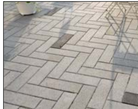
Kalanruotoladonta kartanolankulla ja esimerkkiladontapiirustukset, kuvat: Rudus
