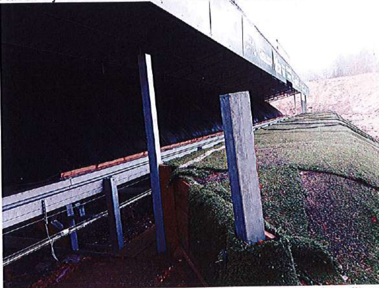
Kuva 7. Luotiloukku kuvattuna "hirkikopilta" päin. Luodit osuvat katoksen alla oleviin kumimattoihin, joiden alla on kumirouhetta. Hirvenjuoksurata näkyy kuvassa kumimattojen edustalla.
