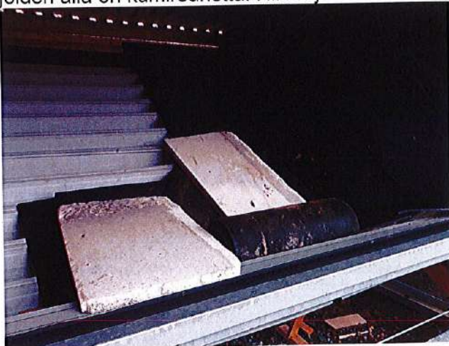
Kuva 8. Luotiloukun rakennetta loukun sivuosassa.
