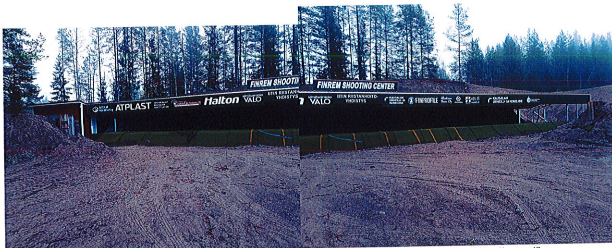
Kuvat 5 ja 6. Luotiloukku, taustavalli ja sivuvallit. Kuvassa 5 vasemmalla "hirkikoppi".
