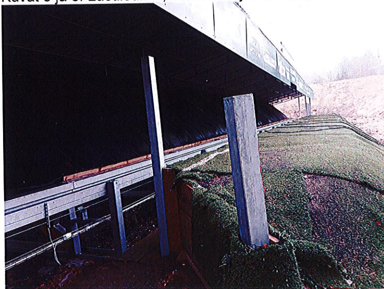
Kuva 7. Luotiloukku kuvattuna "hirkikopilta" päin. Luodit osuvat katoksen alla oleviin kumimattoihin, joiden alla on kumirouhetta. Hirvenjuoksurata näkyy kuvassa kumimattojen edustalla.
