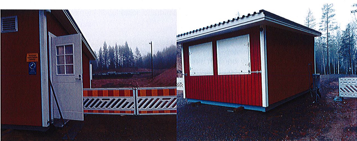
Kuva 1. Ampumakoppi takaa/sivulta, jonka takana näkyy luotiloukku ja taustavalli ja sivulla sivuvalia. Kopin sivuilla oli kevyet kulkuesteet. Kuvassa näkyvässä valaisintolpassa oli valvontakamera.
