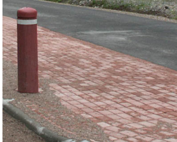
Vuolenkoskella käytettyjä miljöö rakentamisen elementtejä: punainen betonikivi ja punamullatut puiset pollarit.
